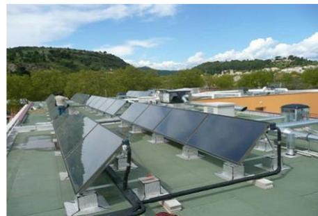
Photo 1 : EHPAD Clermont 84 m<sup>2</sup> de capteurs
