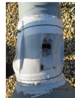
Vérification du système de ventilation
