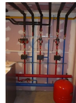
Vérification du système de chauffage
