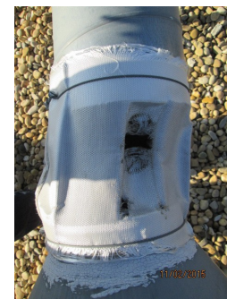
Vérification du système de ventilation
