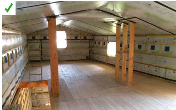
Le plan d'étanchéité à l'air, réalisé à l'aide d'une membrane et de l'adhésif prévus à cet effet, est continu. Un contre tasseautage sera apporté ultérieurement pour obtenir un vide technique et fixer le parement intérieur. ©AQC
