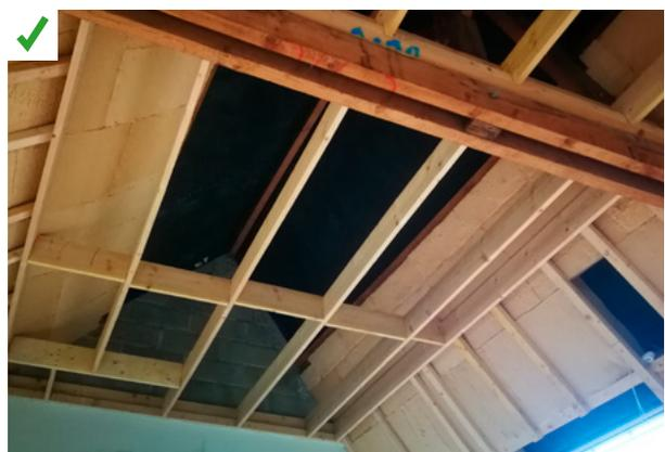
Grâce à des découpes précises et soignées, les panneaux de fibre de bois sont positionnés entre chevrons sans laisser d'espaces vides. La densité des panneaux participe également à leur bonne tenue. Une seconde épaisseur d'isolant en couche croisée sera mise en oeuvre avant la pose de l'étanchéité à l'air.
