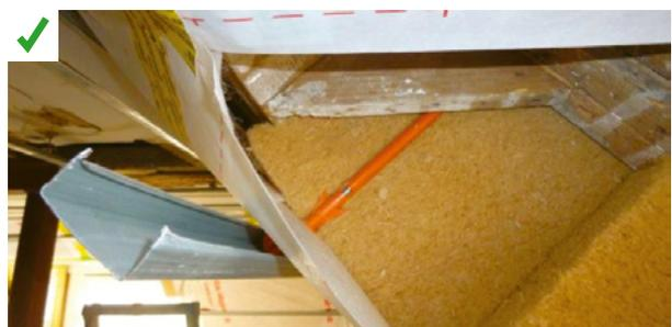
Les suspentes utilisées sont en composite armé pour limiter la conductivité thermique. ©F. Petetin
