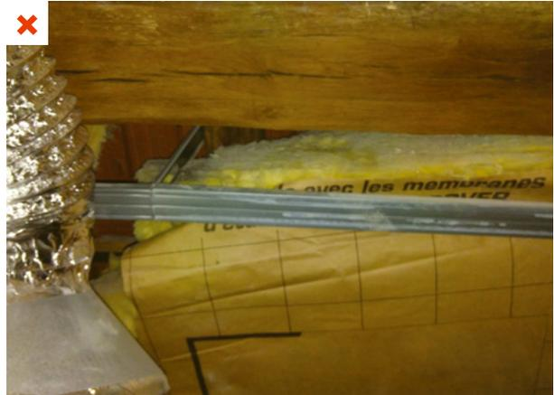
L'isolation est appliquée en une seule couche entre pannes. Des suspentes métalliques sont utilisées pour fixer les fourrures et maintenir l'isolant. Les pannes et les suspentes métalliques traversent le complexe isolant de part en part, créant des ponts thermiques dits intégrés. ©AQOC
