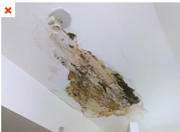
Une fuite est survenue dans une pièce située sous les rampants quelque temps après la réalisation des travaux d'isolation. La reprise de la couverture n'avait pas été prévue lors des travaux de rénovation. ©AQC
