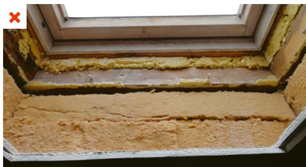
La jonction entre la menuiserie et le chevêtre est assurée par de la mousse expansive. Des vides sont présents entre les panneaux isolants et le chevêtre, ce qui crée un pont thermique. N.B. : Il existe en outre un problème de continuité de l'étanchéité à l'air avec le dormant. ©AQC
