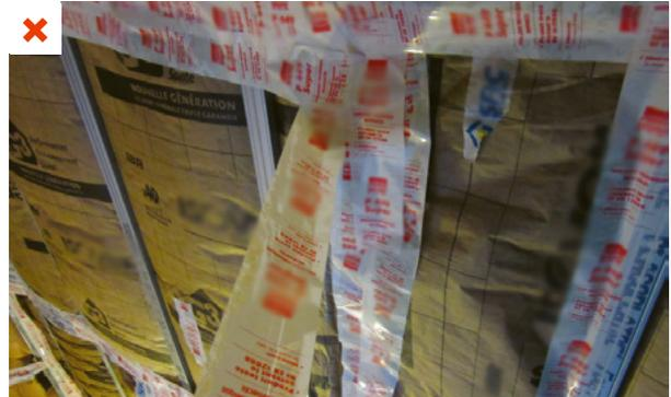
Le surfaçage kraft est considéré à tort comme une membrane d'étanchéité à l'air. La jonction des panneaux est réalisée par du ruban adhésif posé par-dessus les fourrures. Ces deux points ne permettent pas de bénéficier d'une continuité du plan d'étanchéité à l'air. ©AQC
