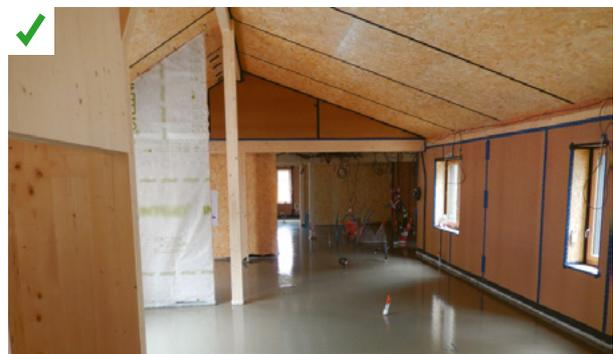
Le plan d'étanchéité à l'air, réalisé à l'aide de panneaux OSB jointés par de l'adhésif prévu à cet effet, est continu. ©AQC
