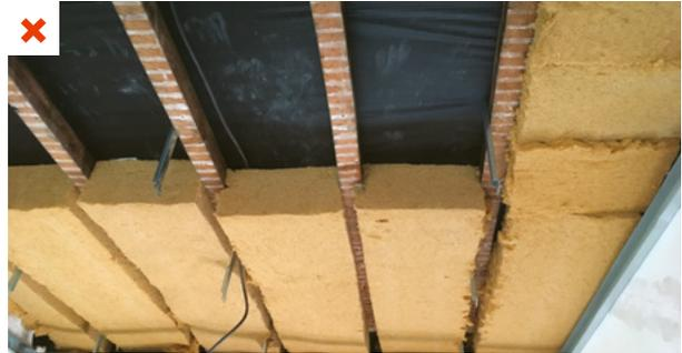
L'écran de sous-toiture installé est mal choisi, car il est fermé à la vapeur d'eau. L'isolant est par ailleurs mis en œuvre directement à son contact, ce qui ne permet pas de pallier le mauvais choix de produit ©AQC
