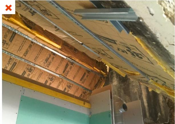
Les extrémités des panneaux isolant ploient sous leur propre poids, notamment au faîtage à la jonction entre les deux pans de toiture. ©M.Auriac
