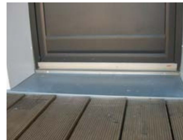
Pose d'un seuil « à la suisse » avec calfeutrement garantissant l'étanchéité à l'air et à l'eau mais non adapté aux PMR. (Crédit photo: AQC)
