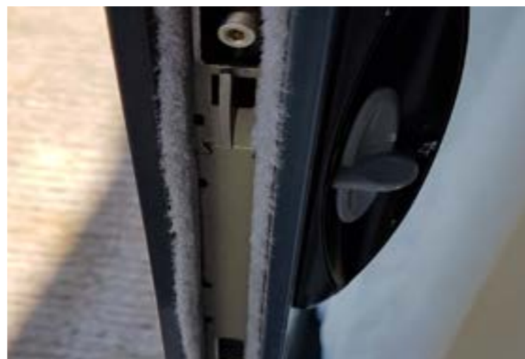
Pièces de fermetures de faible section, fragiles (Crédit photo: Saretec)
