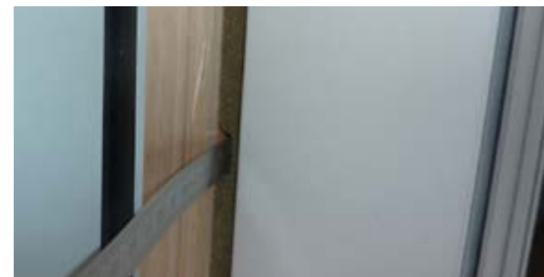
Mousse imprégnée insuffisamment comprimée (Crédit photo: Saretec)
