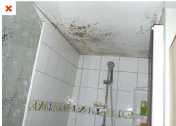
Moisissures liées à un renouvellement d'air insuffisant. ©AQC-2016
