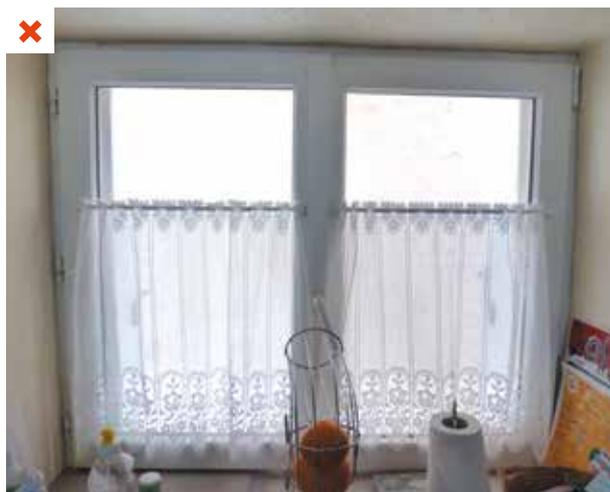
Absence d'entrées d'air - sensation d'humidité très importante dans le logement. ©AQC-2016
