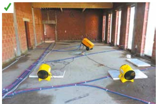
Exemple de dispositif d'assèchement de chantier. ©aerostar
