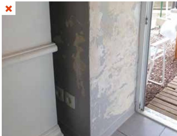
Dégradation des parements et développement de moisissures dues à des remontées capillaires apparues suite à la pose d'un film étanche sous le plancher bas. ©AQC-2016
