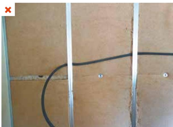
Ponts thermiques au niveau de l'ossature métallique traversante et des jonctions entre panneaux d'isolant (photo prise avant la pose du parement intérieur). ©AQC-2016
