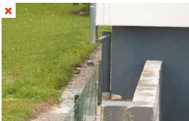
Descente d'eaux pluviales non raccordée à l'évacuation, du fait d'un décalage causé par la pose de l'ITE. ©AQC-2016
