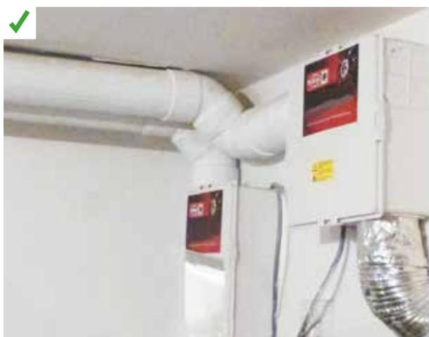
Système de ventilation forcée d'une lame d'air entre l'isolation thermique et le mur humide, permettant d'évacuer l'humidité excédentaire. ©AQC-2016
