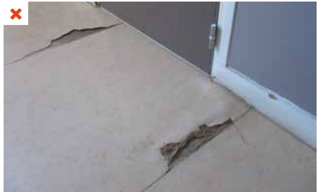
✗ Linoléum qui a cloqué puis s'est percé suite à l'accumulation d'eau en sous-face. ©AQC-2016
