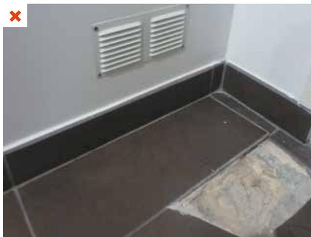
Accentuation de l'humidité dans le sol suite au doublage des murs qui a favorisé les remontées capillaires en empêchant le mur de sécher : il en a résulté un décollement du carrelage. ©AQC-2016
