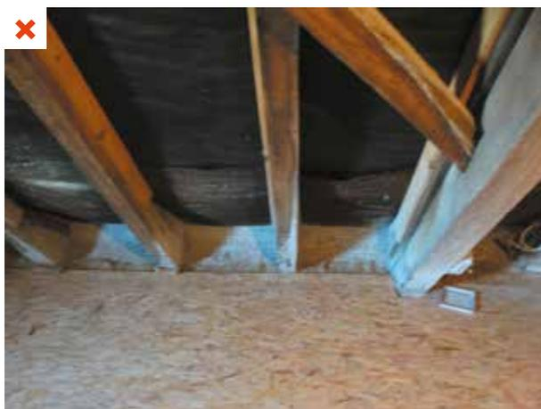
Platelage en OSB d'un plancher haut, situé du côté extérieur de l'isolation, et jointoyé. ©AQC-2016
