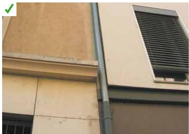
Descente d'eau pluviale non encastrée dans le complexe isolant (ITE). ©AQC-2016
