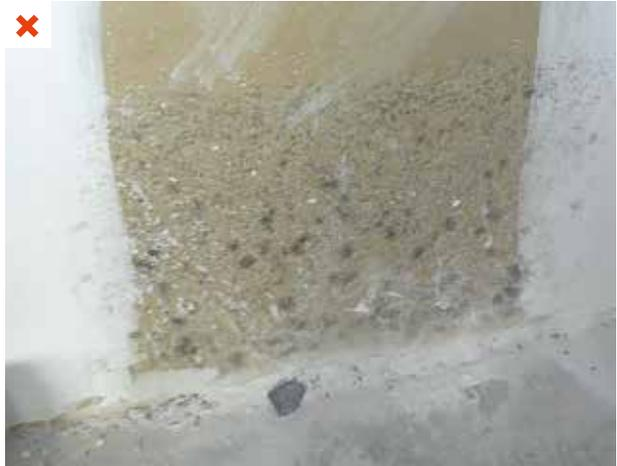
Apparition de moisissures en pied de mur, du fait d'une humidité trop importante au cours du chantier. ©AQC-2016
