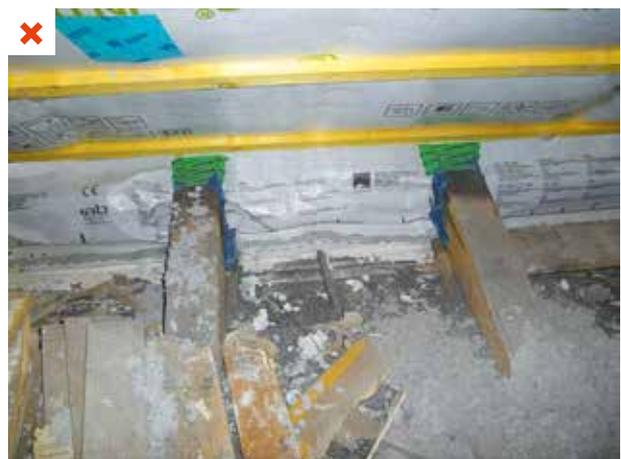
Phénomène de condensation au niveau des têtes de solives, renforcé par l'absence de ventilation de chantier. ©AQC-2016
