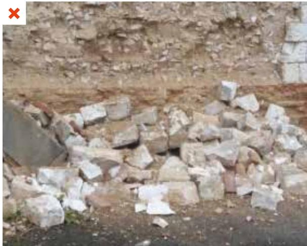
Effondrement d'un mur sur la moitié extérieure de son épaisseur, dû à une concentration trop importante d'eau liée à des infiltrations derrière un enduit ciment. ©AQC-2016
