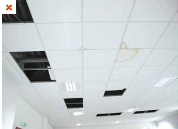
Dégradation du faux-plafond provenant d'une mauvaise jonction entre canalisations existantes et neuves, qui a entraîné une fuite. ©AQC-2016
