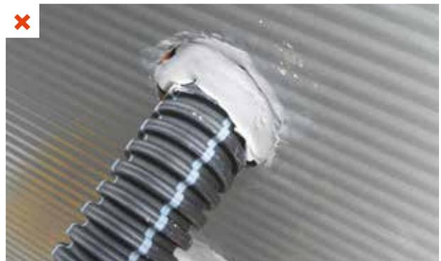
Utilisation d'un produit inadapté à l'étanchéité à l'air, ne comblant pas totalement le perçement et non durable dans le temps. ©AQC-2016
