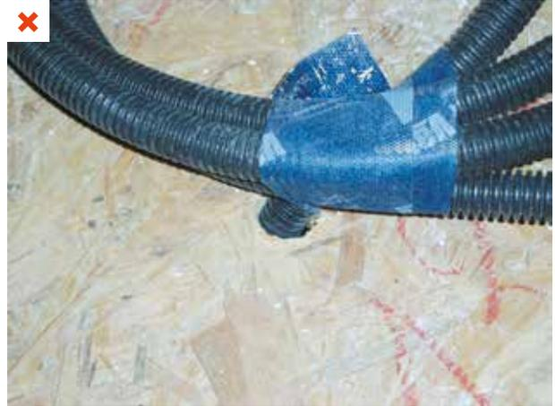
Perçement du plan d'étanchéité à l'air non rebouché. ©AQC-2016
