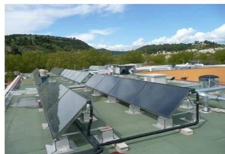
Photo 1: EHPAD Clermont 84 m 2 de capteurs
