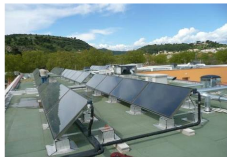
Photo 1 : EHPAD Clermont 84 m 2 de capteurs
